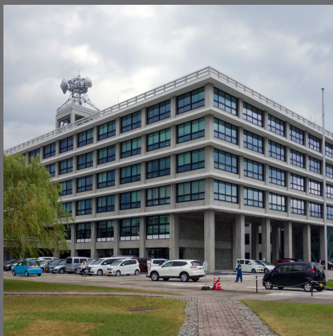
島根県庁舎 (安田臣設計 / 1959年)
