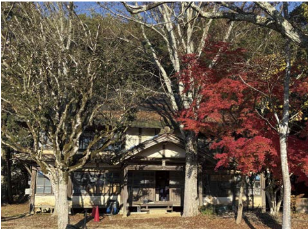
正面外観 (樹木により全景の見通しが困難)
