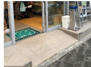
スロープの設置
