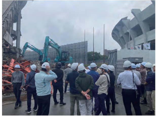
【解体現場の様子】
