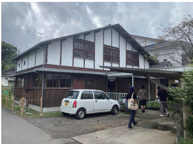
【 改修工事を終えた牧師館の全景 】
