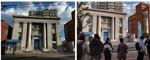
外壁は花崗岩だろうか、トスカナ式円柱と付柱がシンメトリー配置で重厚感がある。銀行は古典主義を基本として由緒のある様式をまとうことが多い。更に、この建物は免震基礎を用いていることに驚愕。地下室に両端がピン接合となった免震柱を設置し、地震力の低減をしているというテクニカルな建物だ。世界的に見ても当時から日本人の技術力には凄いものがあつたのではと思う。1923年の関東大震災から意識が高まっていたのだろう。古典的だが威厳の在るシンプルさで現代の銀行形態としてもじっくりくる感じだ。
