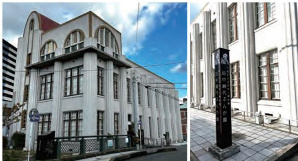
欧州の新建築運動の影響を受け、歴史主義からモダニズムへの過程期（近代建築運動）のシンプルモダンな建物で、局面の塔屋（ヴォールト屋根）や飾りをもたない付柱が2階窓上部の薄い庇の上に露出している新しい造形。柱はパルテノン神殿を彷彿させる。驚いたのが、内田式流水防火装置で、火災時には塔屋の水槽（40トン貯水）から2階窓上部の四角い穴から放水され特許をとっているという。なんて斬新な。妻面窓は長方形窓を3分割、RC化に伴い開口部が大きくなっている。近代化の波を感じる。
