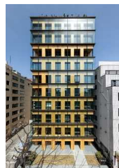
純木造 11階建て研修所
