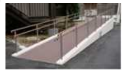
スロープの設置
