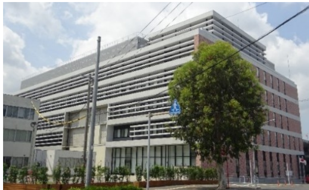
宇部市役所新庁舎
