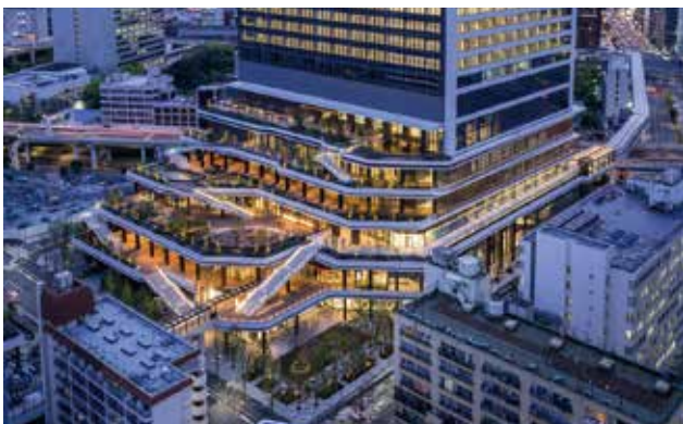
東京ポートシティ竹芝オフィスタワーのスキップテラス全景。1～6階へと、立体的に緑あふれるオープンスペースが展開している。
