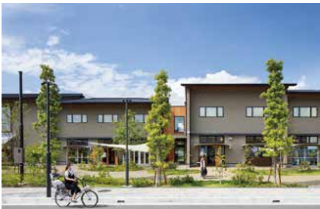
商業・オフィス棟は、一棟の建物であるが、建物を雁行させ、それぞれの建物高さを変えることで、小さな商店の連なりに見えるように配慮している。
