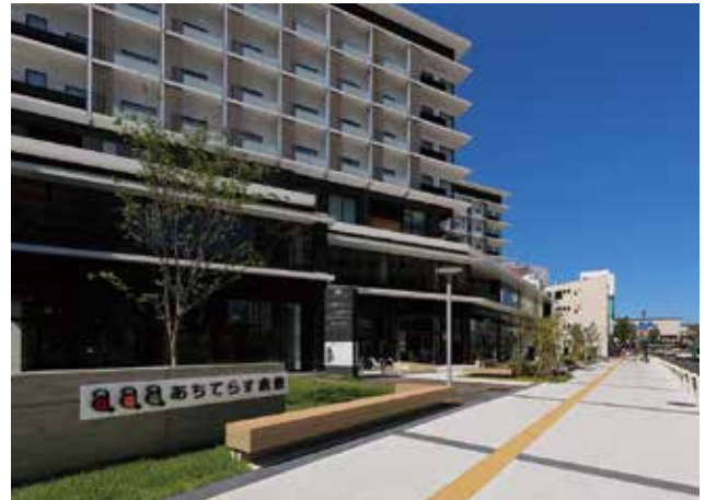
東側の公共空地。 ガラスサッシを採用して店舗の賑わいが外部に滲み出すよう演出。
