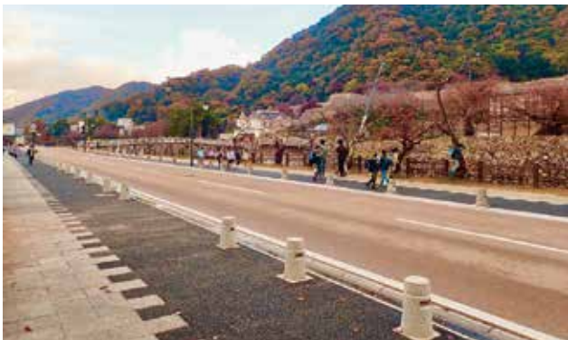
街なみ環境整備事業により美装化、無電柱化、歩道拡幅を行ったお堀端通り。歩道拡幅により、生徒の通学時における安全性が確保された。
