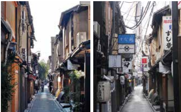
屋外広告物の自主改善事業を実施、令和3年に無電柱化事業が完了し、花街の景観は大きく改善した。（左：2021年10月、右：2012年3月）
