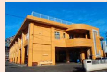
補助事例：久留米市環境部庁舎(福岡県久留米市)
