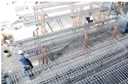
梁鉄筋工場地組
