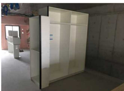
押入れ・物入れのユニット
